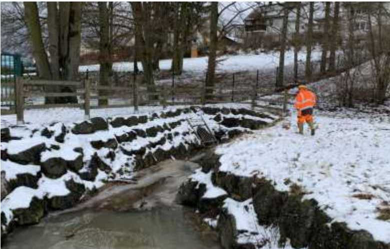
Einlaufbereich Gartenbach in die städtische Verrohrung
