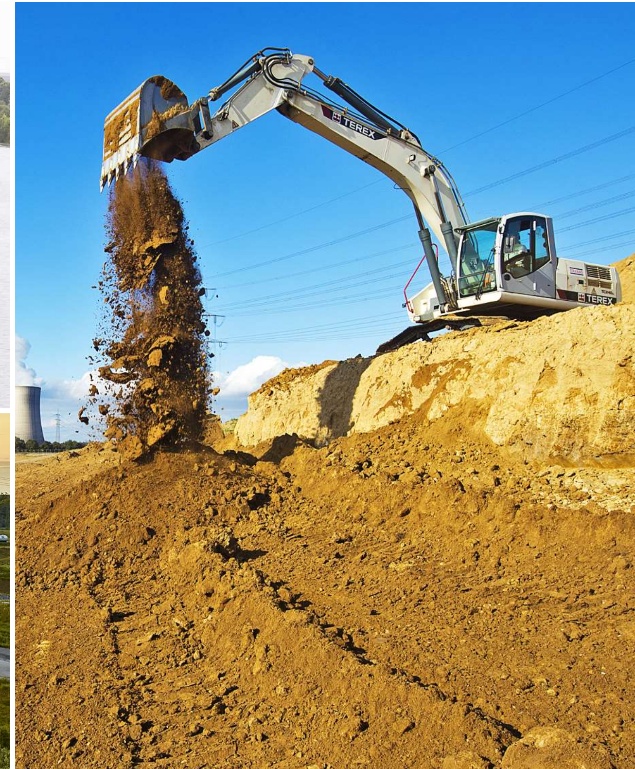
Baufeld Emscher-Mündung in Dinslaken
