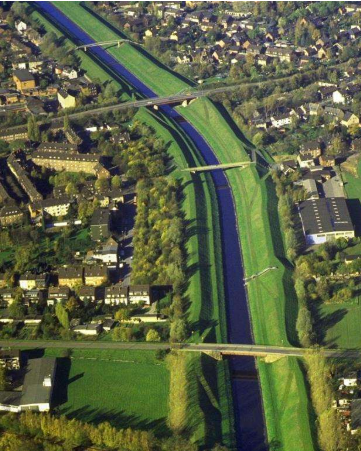
Deichstrecken und Platzmangel
