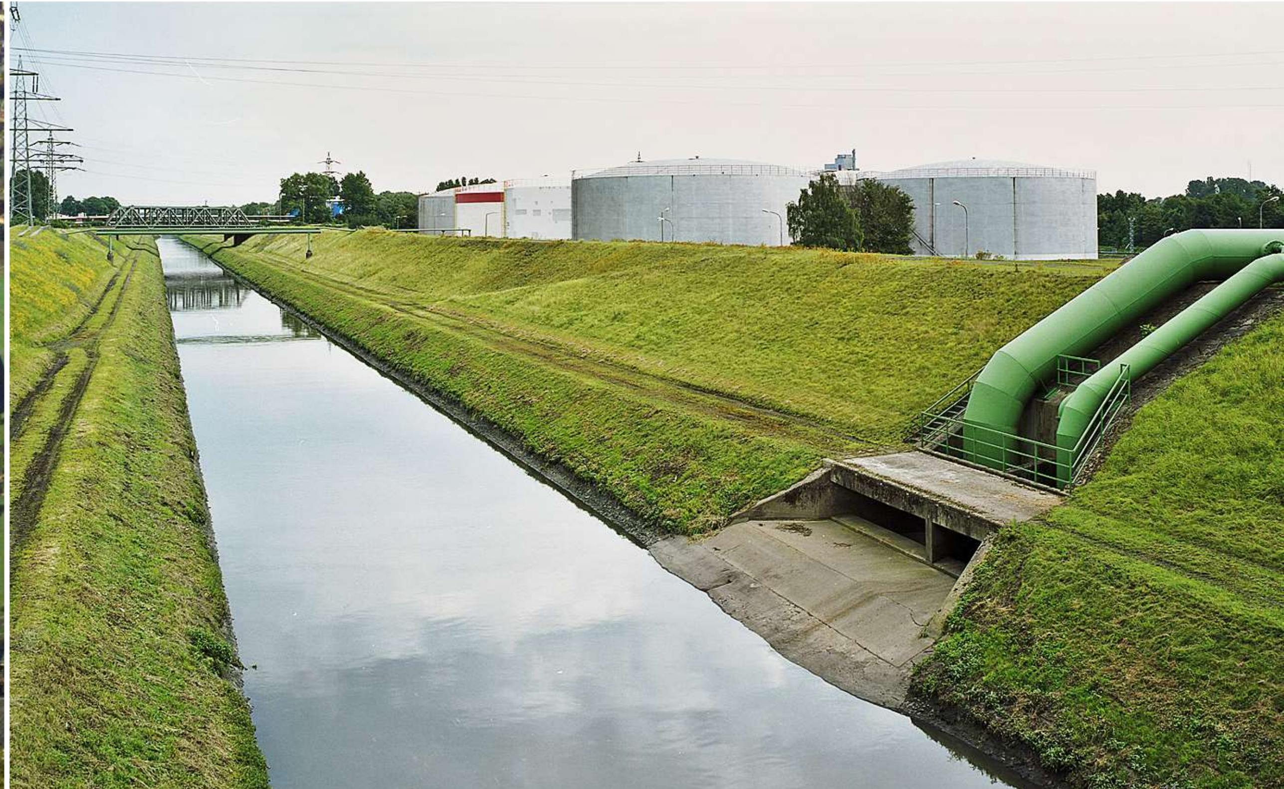
Bachpumpwerke und Düker
