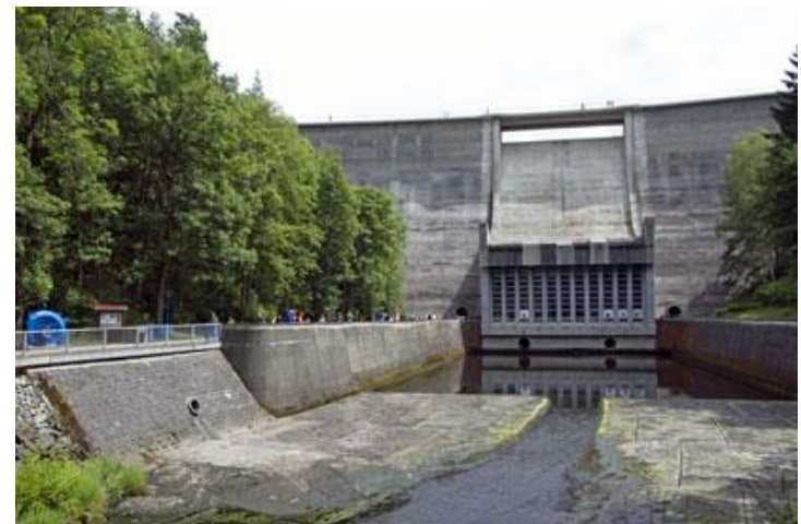
Tosbecken Talsperre Pöhl (LTV, Sven Beyer)
