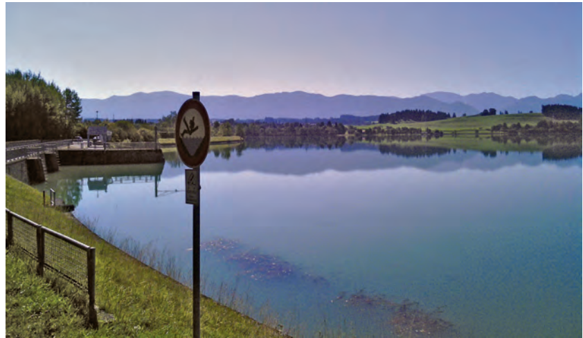
Hochwasserschutzanlage am Lech mit Alpenpanorama
