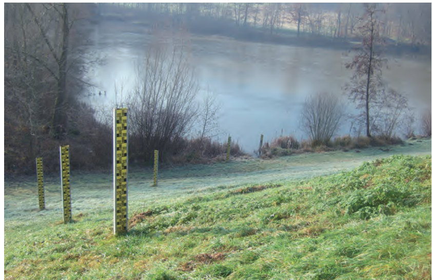
Hochwasserrückhalteraum an der Rems
