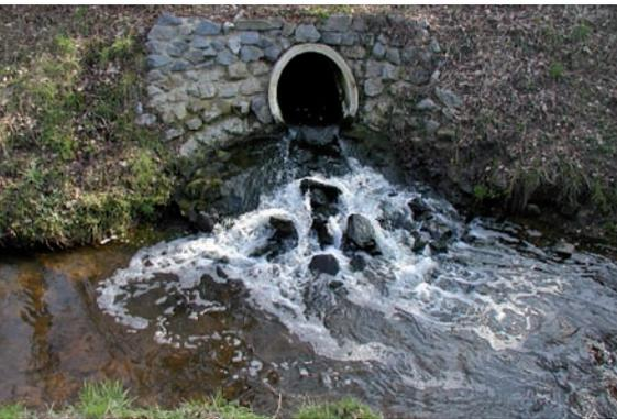
Der Nachweis der Verträglichkeit einer Misch- oder Niederschlagswassereinleitung für ein Gewässer wird in Nordrhein-Westfalen und Hessen i.d.R auf Grundlage der Merkblätter BWK M3 und BWK M7 geführt. Sie fordern je nach Einleitungsstelle und -art eine Untersuchung der hydraulischen, hydrologischen bzw. stofflichen Auswirkungen der Einleitung.
