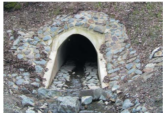
Die Bilder zu diesem Bericht zeigen die Umgestaltung des Hesperbachs in Essen am Durchlass Zechenweg.
