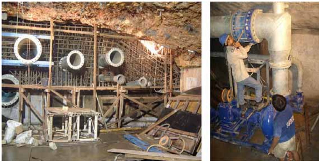
Abb. 8: Vorbereitung der Betonierarbeiten am Sperrwerk (links) und Installation der KSB-Fördermodule (rechts)
