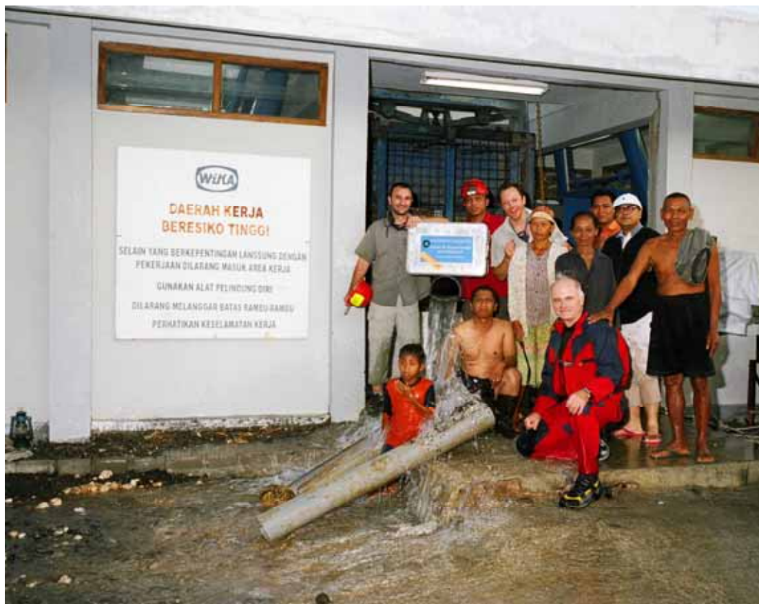
Abb. 9: Erfolgreicher Probeinstau und Inbetriebnahme (August 2008)
